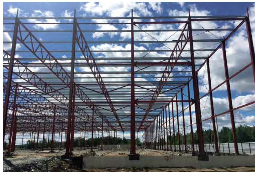
Монтаж каркаса здания
