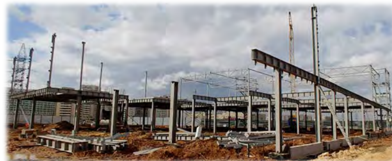
Монтаж каркаса здания
