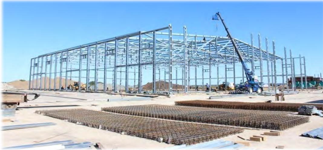
Монтаж каркаса здания
