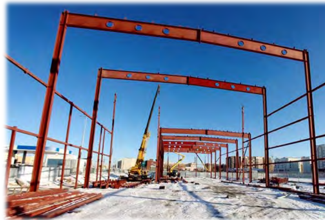
Монтаж каркаса здания
