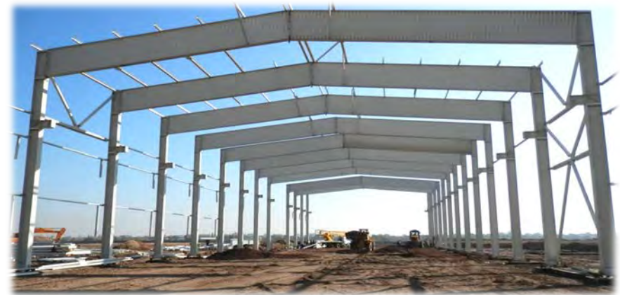
Монтаж каркаса производственного блока
