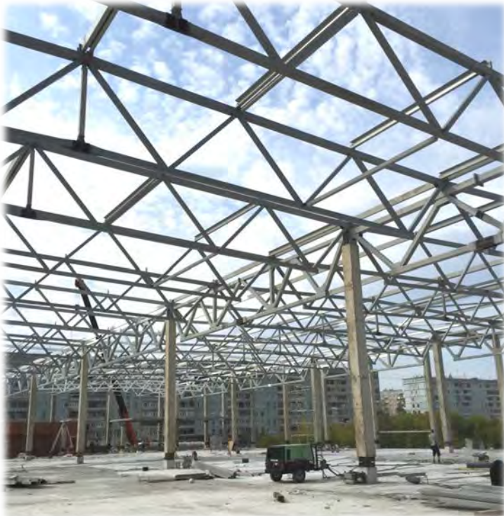
Монтаж каркаса здания
