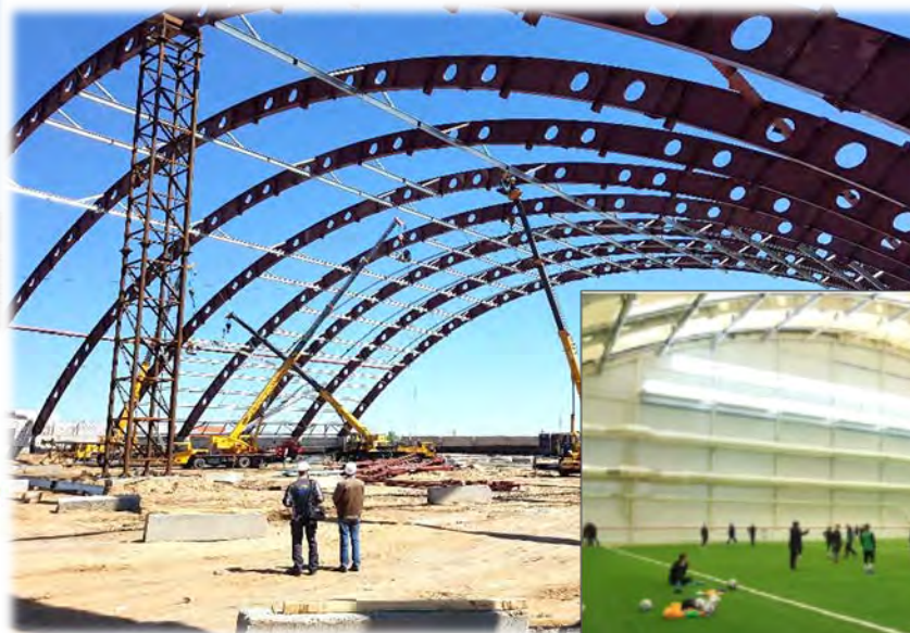
Монтаж каркаса здания
