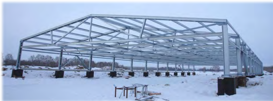
Монтаж каркаса Свинокомплекса
