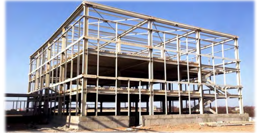
Монтаж каркаса офисного здания
